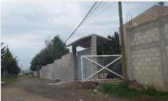
Foto no. 32 Entrada de viviendas sobre Av. del Nevado
